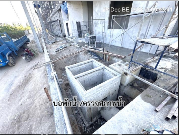
บริเวณตำแหน่งก่อสร้างบ่อหน่วงน้ำ และบ่อพักน้ำก่อนระบายออกสู่ท่อสาธารณะบริเวณด้านหน้าโครงการ
