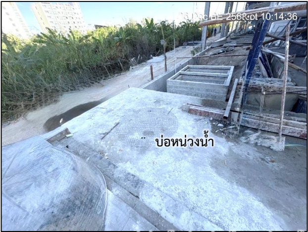
บริเวณตำแหน่งก่อสร้างบ่อหน่วงน้ำ และบ่อพักน้ำก่อนระบายออกสู่ท่อสาธารณะบริเวณด้านหน้าโครงการ
